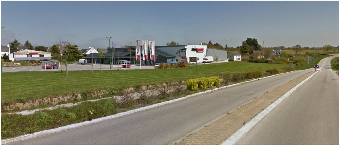
Entrée rocade Surzur, RD20 (contexte de mise en scène paysagère)
